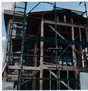
授与所新築工事 骨組み全体
